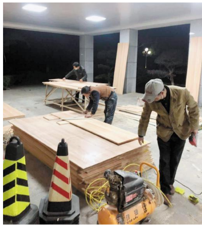
施工工人不分白天抢工期。
