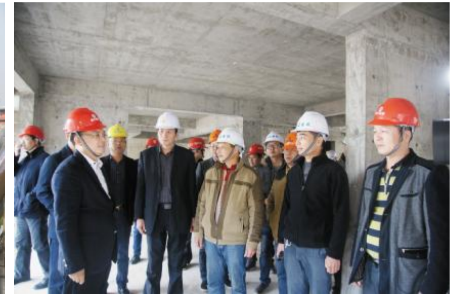
长沙市开福区委副书记、区长沈裕禄一行到我司板塘项目工地视察
